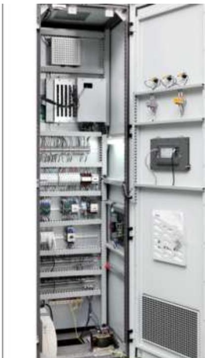
Рис 3.8 Расположение компонентов в шкафу управления
