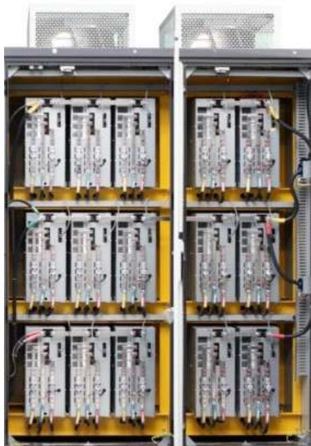
Рис 3.7 Расположение компонентов в шкафу силовых модулей
